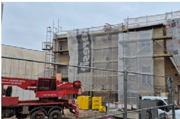
Zadní část budovy, probíhající rekonstrukce
